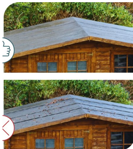
Hore správne · dole nesprávne (nečistoty na debnení)
